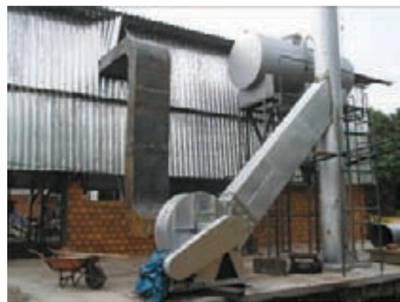
Figura 11.14 – Conjunto de exaustão de gases e tanque de condensado
