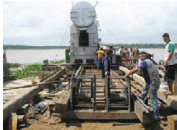
Figura 11.10 – Infra-estrutura utilizada para o transporte da caldeira da balsa até o local de instalação
