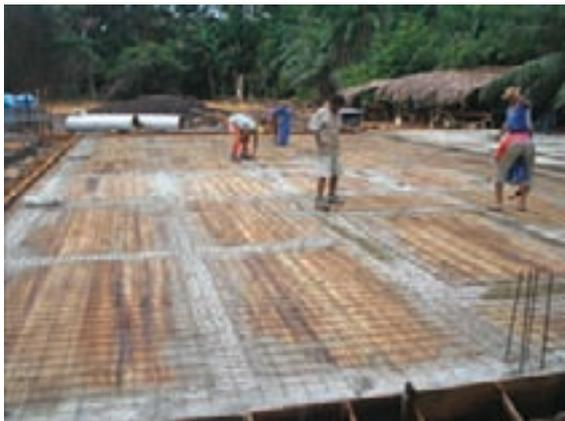
Figura 11.7 – Detalhes da construção da laje da usina de geração de energia elétrica
