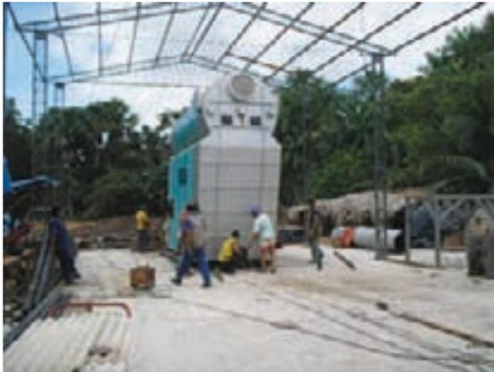
Figura 11.9 – Caldeira sendo fixada na base
