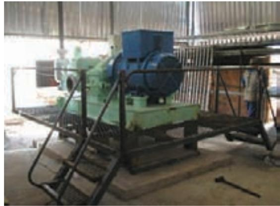
Figura 11.12 – Turbo-gerador já instalado em sua base
