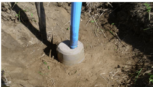
Figura 6.3 Poço tubular raso construído no Neossolo
