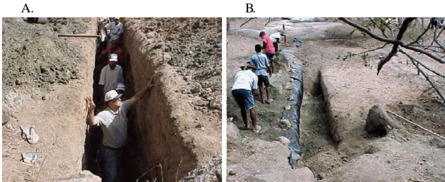
Figura 1.7 Abertura de trincheira para construção de barragem subterrânea (A) e vista de septo de lona plástica já instalada (B)
