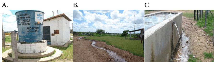
Figura 9.2 Estação de tratamento de água salobra (A) e descarte do rejeito salino no solo e no curso d’água (B) e (C)
