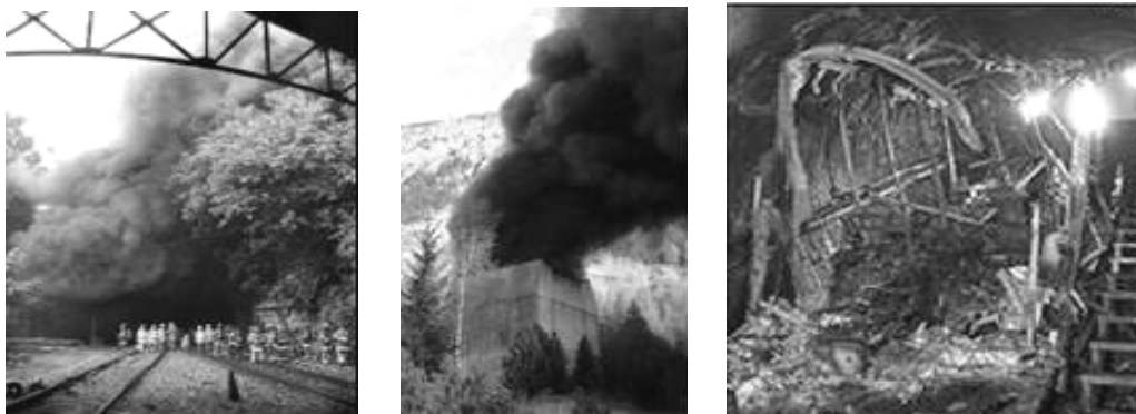
Figura 3.58 – Gases e fumaça pela boca da mina e chaminé, e resultados dos danos provocados pelo incêndio em ambiente subterrâneo
