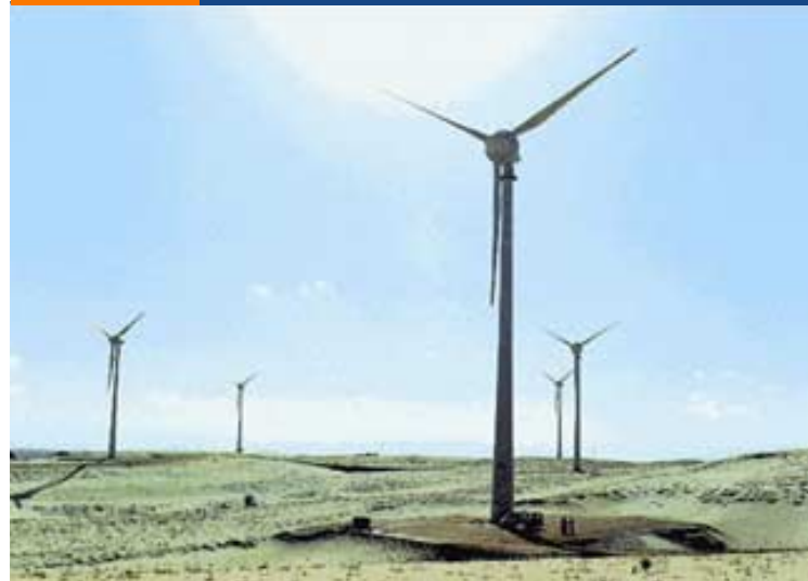
FIGURA 6.10 Central Eólica de Taíba (São Gonçalo do Amarante – CE)
