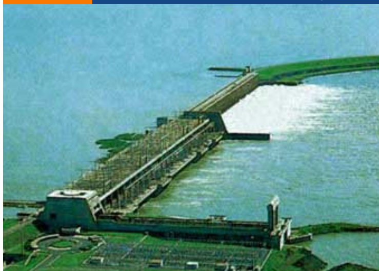
FIGURA 4.7 Usina Hidrelétrica de Jupia (Três Lagoas – SP)
