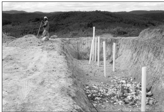
Figura 5.28 Recobrimento diário.
