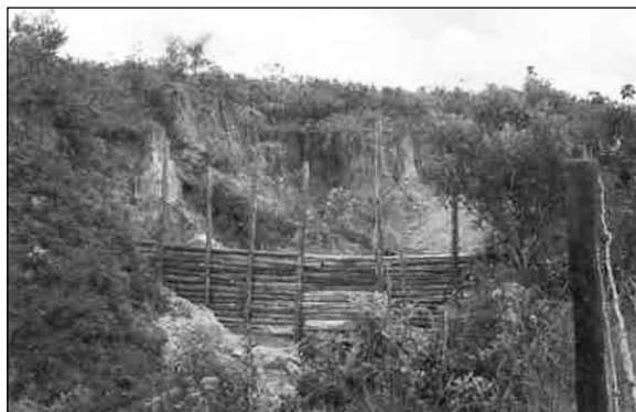
Figura 5.9 Sistema de contenção das erosões.
