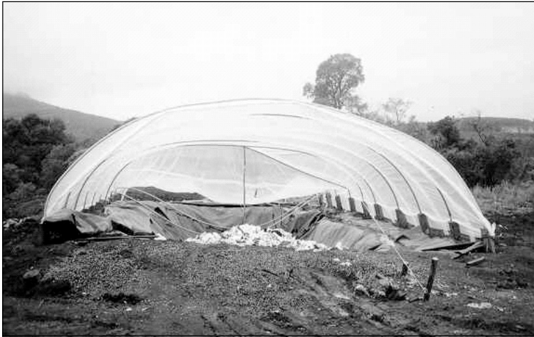
Figura 3.5 Proposta de telhado móvel.
