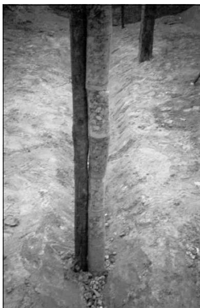
Figura 5.22 Sistema de drenagem de gases.
