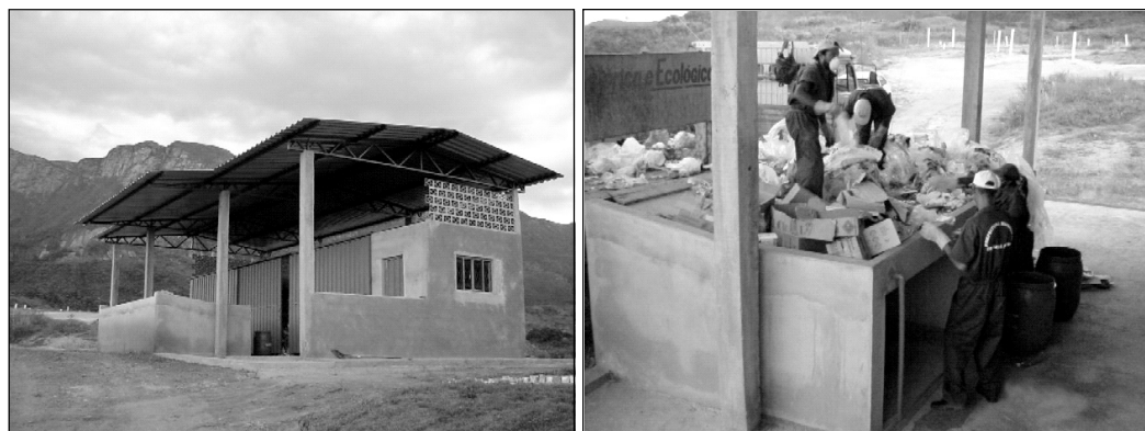
Figura 5.41 Galpão de triagem.
