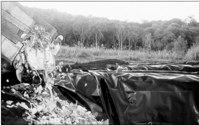
Figura 3.12 Preenchimento das trincheiras.
