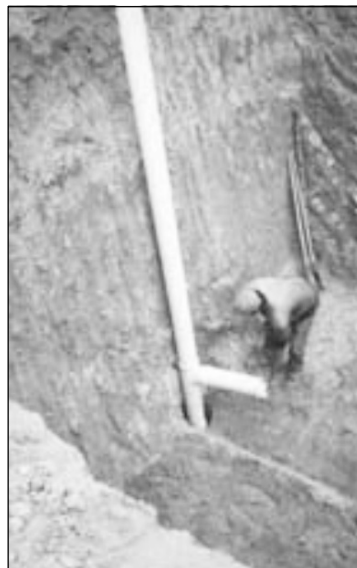
Figura 5.21 Detalhe poço de captação e amostragem.
