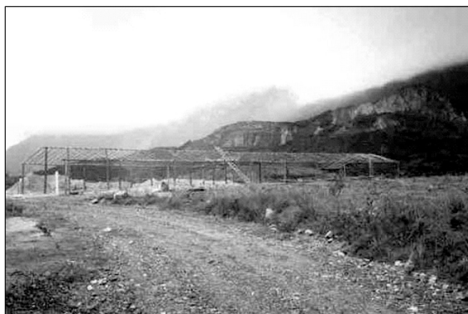
Figura 5.17 Vias de acesso.
