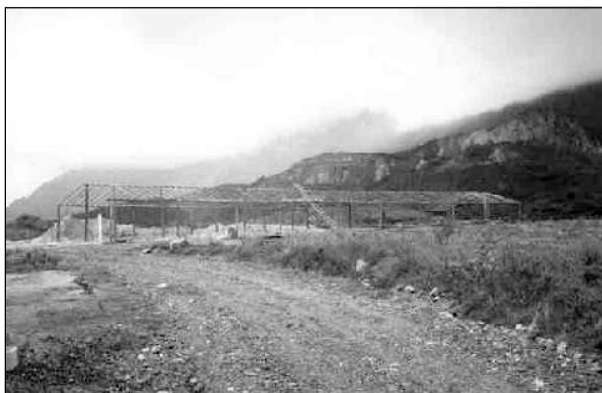
Figura 5.19 Cobertura temporária das trincheiras.
