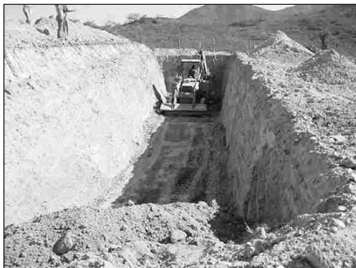
Figura 5.24 Abertura da trincheira.
