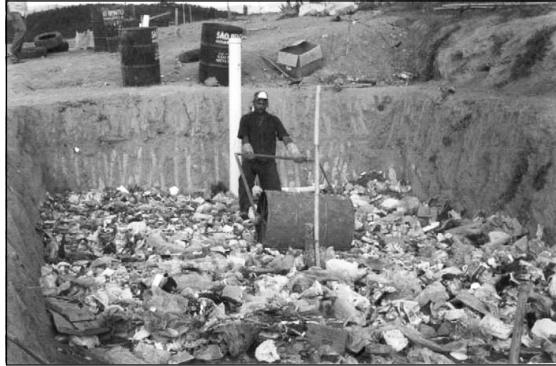
Figura 5.27 Compactação do resíduo.
