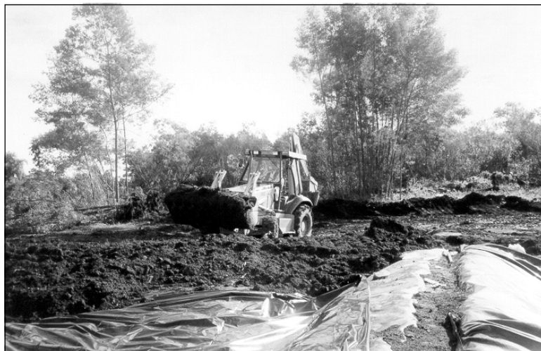
Figura 3.4 Cobertura final com manta de PVC e solo local compactado.
