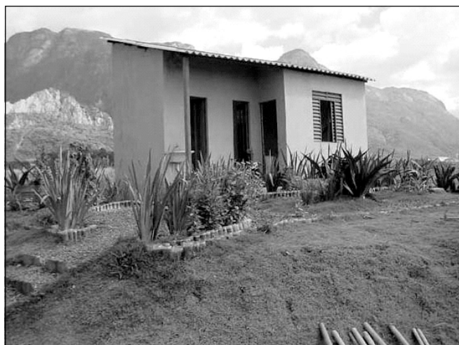
Figura 5.16 Casa de apoio.
