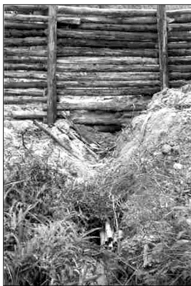
Figura 5.10 Detalhe do sistema de drenagem.
