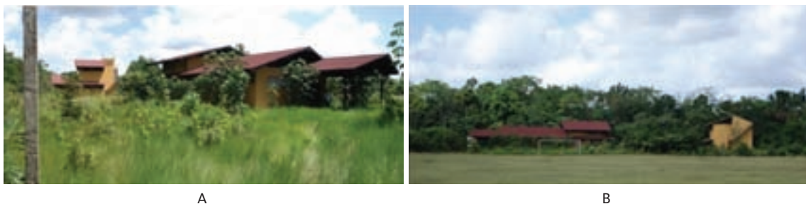
Figura 3.9 – Vista do Complexo. Na figura A vê-se o prédio da usina de gasificação ao fundo; à direita a usina de beneficiamento de açaí; e em primeiro plano um dos postes de madeira implantados. Em B tem-se uma visão geral da implantação do complexo.
