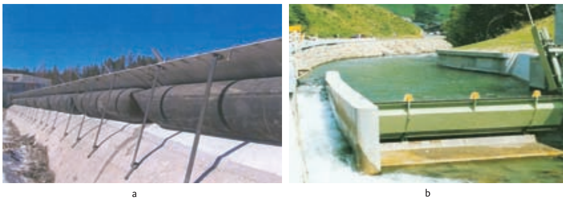
Figura 2.27 – Barragens móveis: (a) operada por meio de colchões infláveis; (b) operada por pistão óleo-hidráulico
