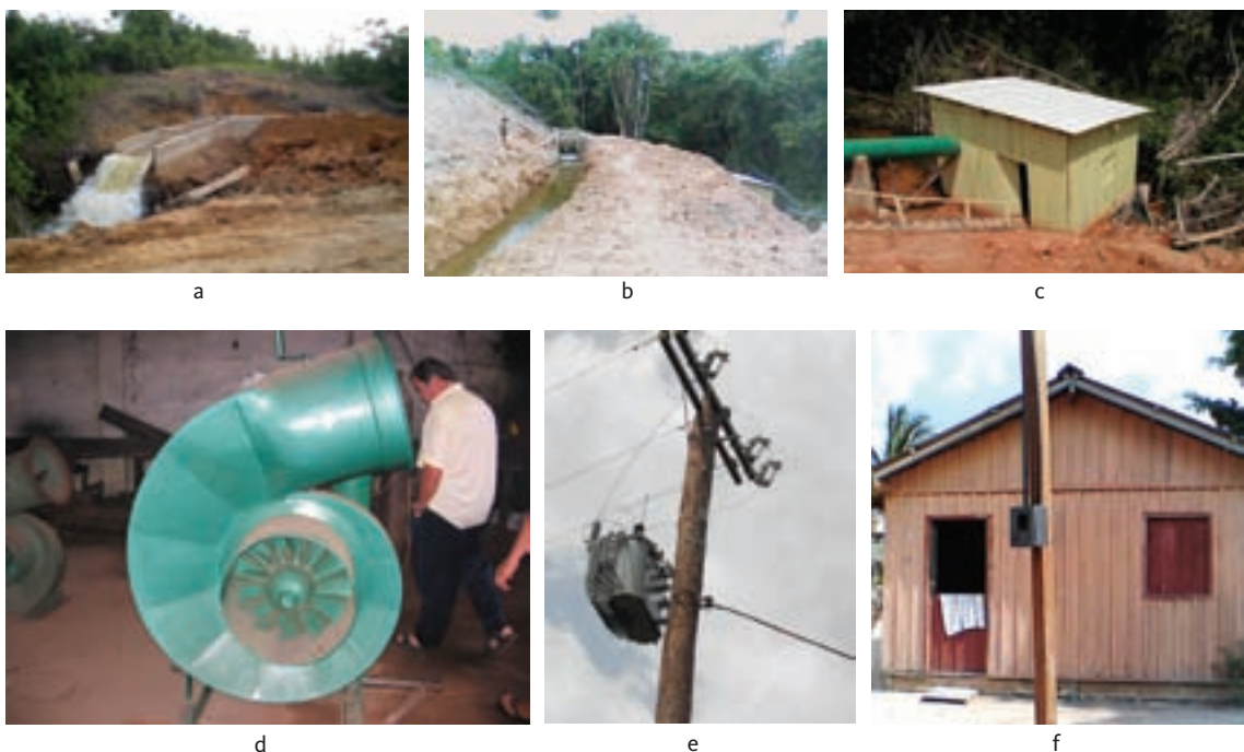
Figura 2.35 – Projeto \mu CH Jatoarana: (a) barragem de terra com vertedor lateral; (b) casa de máquinas; (c) canal de adução, escavado em terra sem revestimento; (d) turbina hidráulica tipo Indalma; (e) linha de transmissão; (f) habitação sendo atendida
