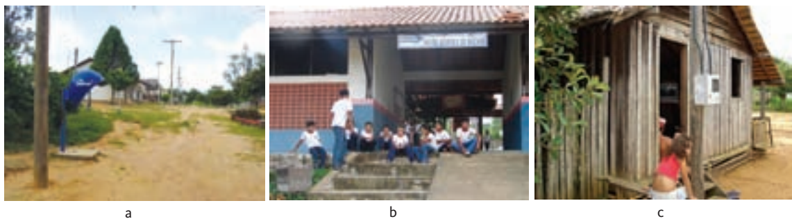
Figura 2.30 – Atendimento à comunidade de Aruã: (a) linha de transmissão e distribuição; (b) escola atendida pelo projeto; (c) habitação atendida pelo projeto
