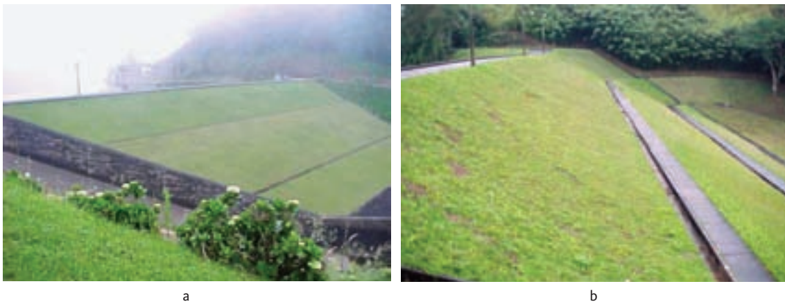
Figura 2.23 – Barragem de terra homogênea: (a) PCH Palmeiras; (b) PCH Piau
