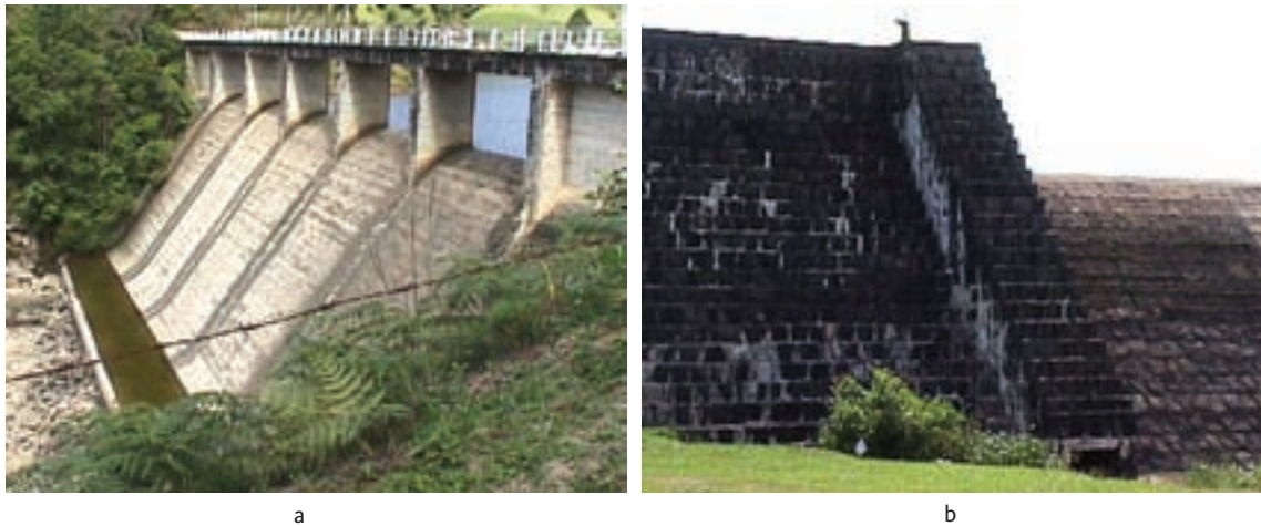
Figura 2.25 – (a) Barragem de concreto; (b) barragem de pedra argamassada
